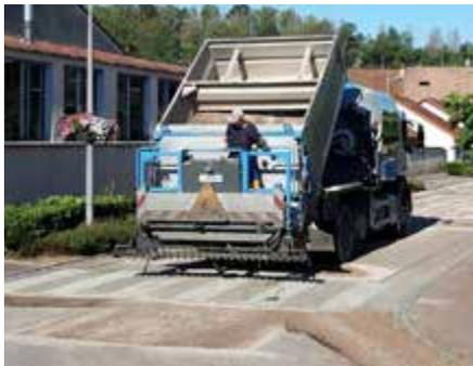
En hiver, l'eau s'infiltré dans les fissures et avec le gel la chaussée casse et forme des nids de poules. Pour enrayer ce phénomène à moindre coût, il n'y a vraiment qu'une solution adaptée, c'est le gravillonnage.
